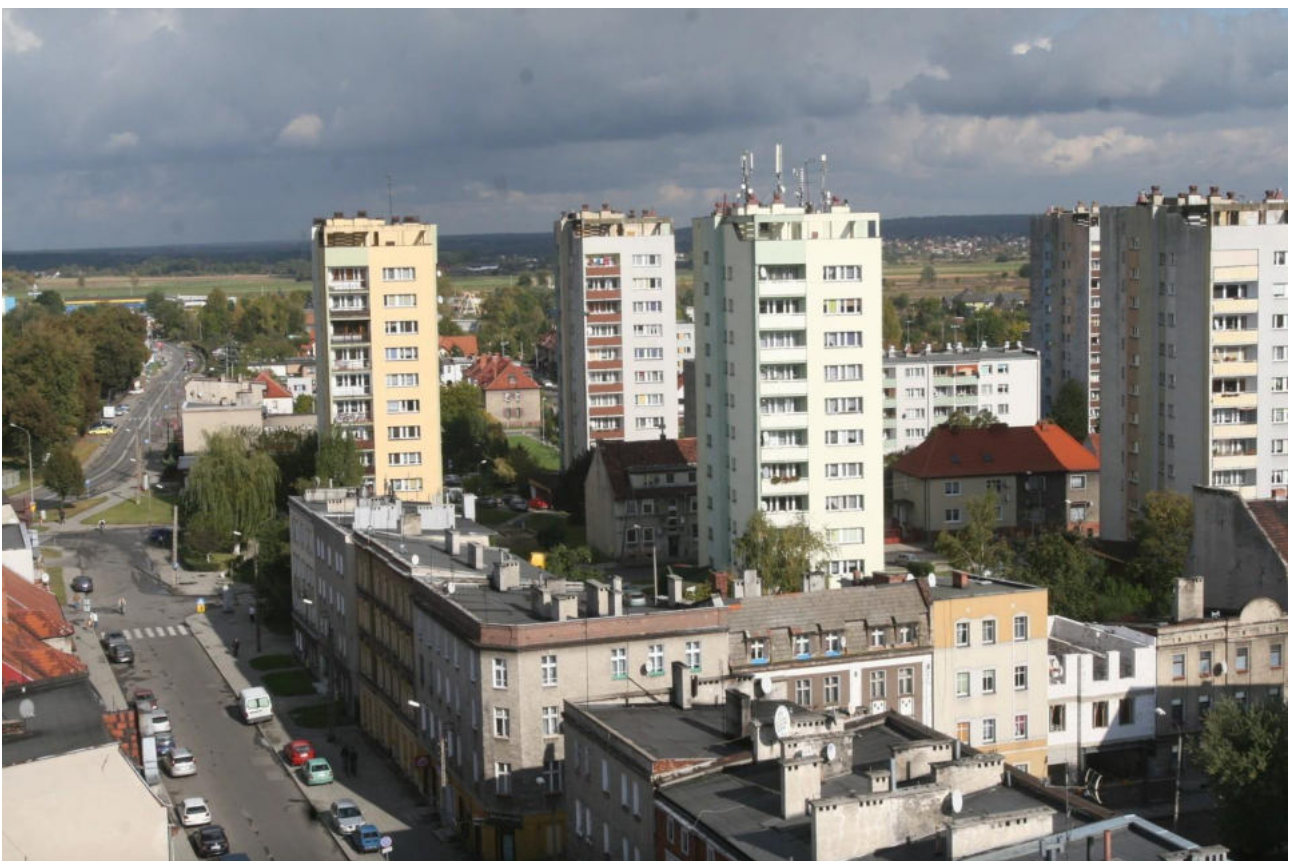
Wyprostowane budynki nr 4 (żółty) i nr 9 (jasnozielony) w 2018 roku.
