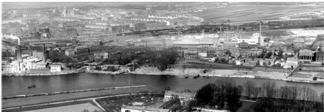
Wyspa Bolko, rzeka Odra oraz 3 cementownie z lotu ptaka (Grundmann, Giesel, Pringsheim)
